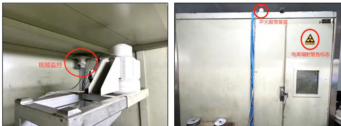
图 10-3 防护铅房现有安全装置照片
